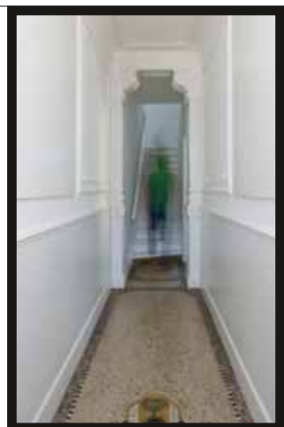
Hierboven: de vloer van blauwe en rode granito met mozaïekboord in de gang bleef bewaard, net als de moulures, die geschilderd en gerestaureerd werden. De trap werd opgeschuurd en wit geverfd.
